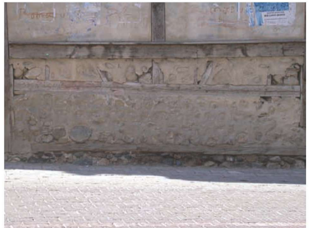
Res. 6. Geleneksel Boyabat evleri su basman seviyesine kadar moloz taşlardan inşa edilmiştir (gözl. no: F33.JB3.2).
