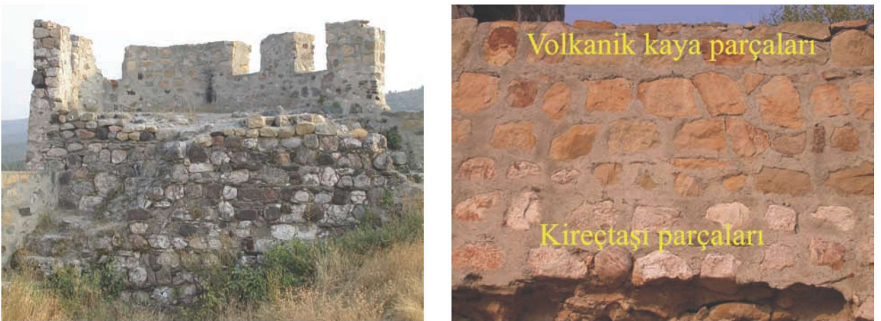
Res. 11 a-b. Boyabat Kalesinin inşasında ve farklı restorasyon dönemlerinde kullanılan doğal yapı taşları (gözl. no: F33.JA3.1).
