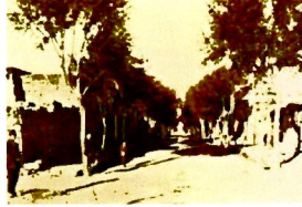
39 Mübâ Medresesi'nin Üzerinden Geçen Yol
