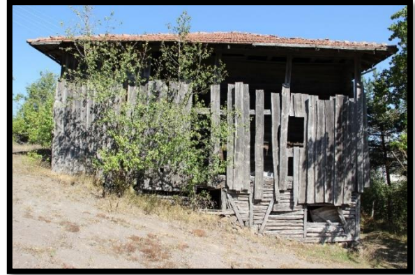
Fotoğraf-5: Batı Cephe
