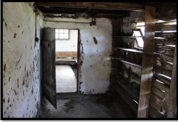
Fotoğraf-10: Zemin Kat Giriş Mekanının Doğusu
