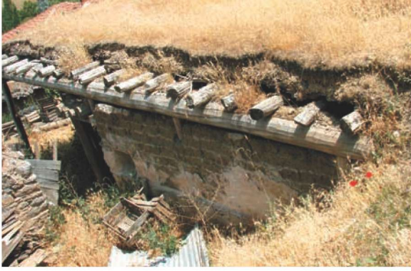
Res.13- Düz dam yapım sistemi
