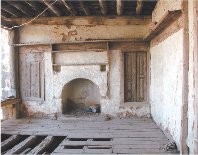
Res.15- Hayat mekanında ocak, pencere ve dolabın görünümü
