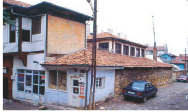
Res.10- İsfendiyar Bey Hamamı güney görünüşü
