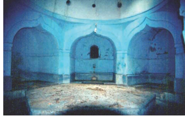
Res.45- Ferhad Paşa Hamamı sıcaklık mekanı
