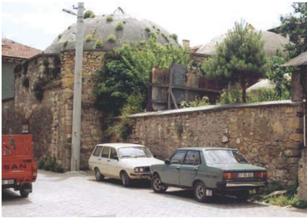
Res.35- Çifte Hamam (Halimi Çelebi Hamamı) doğu görünüşü
