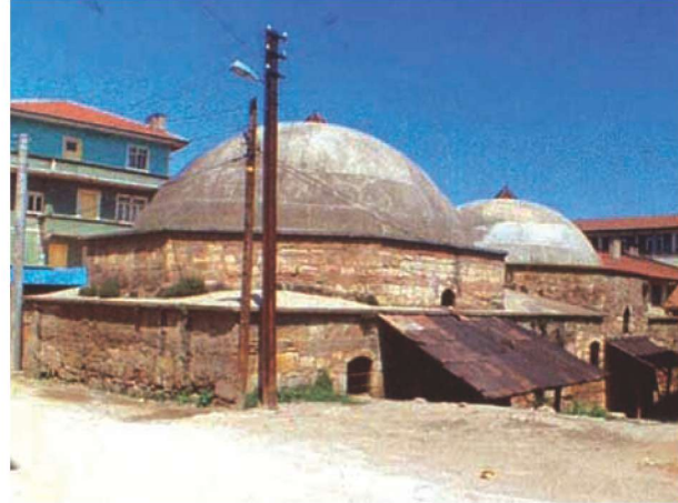
Res.34- Çifte Hamam (Halimi Çelebi Hamamı) güney görünüşü
