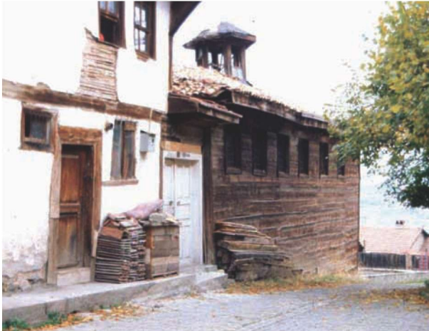
Res.24- Kale (Saray) Hamamı güney görünüşü
