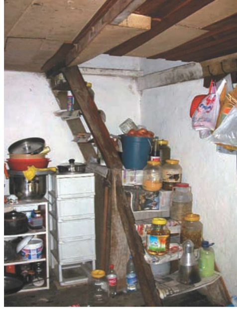
Res.21- Mutfak merdiveni
