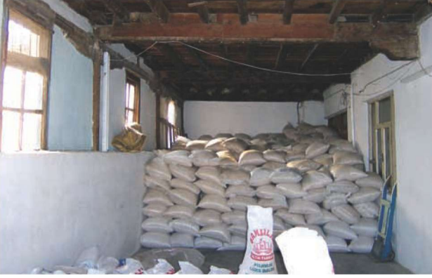
Res.32- Şamlılar Çeltik Fabrikası, paketlenme+depo mekanı
