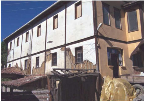
Res.26- Şamlılar Çeltik Fabrikası, güneybatı cephesi
