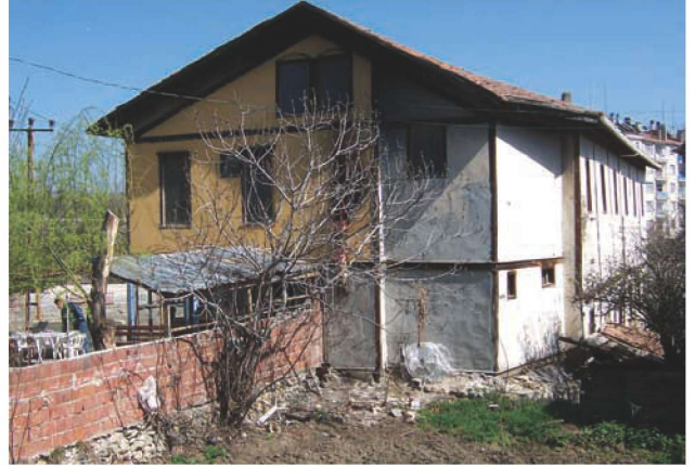
Res.25- Şamlılar Çeltik Fabrikası, kuzeybatı cephesi
