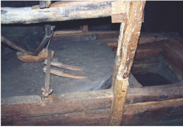
Res.8- Gazidere Tabaklısı Köyü, Ahmet Bican Değirmeni, detay görünüm
