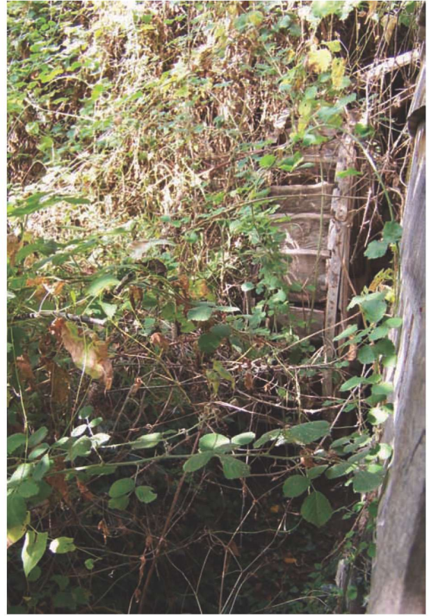
Res.13- Gazidere Tabaklısı Köyü Ahmet-Nazım Yılmaz Değirmeni, su çarkı görünümü
