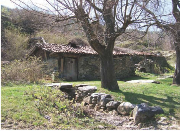
Res.6- Gazidere Tabaklısı Köyü, Ahmet Bican Değirmeni ve ark
