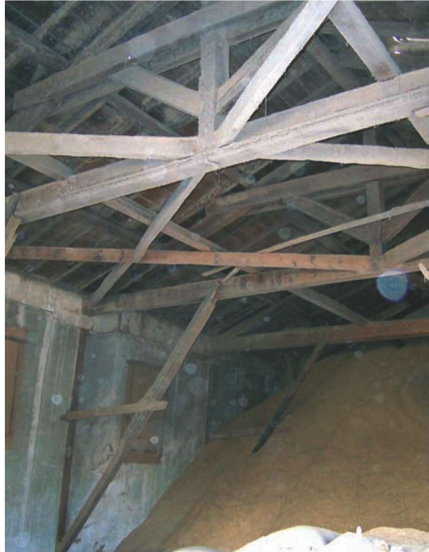
Res.36- Şamlılar Çeltik Fabrikası, ikinci kat ahşap çatı taşıyıcı sistemi ve mekan içinde toplanan çeltik kabukları
