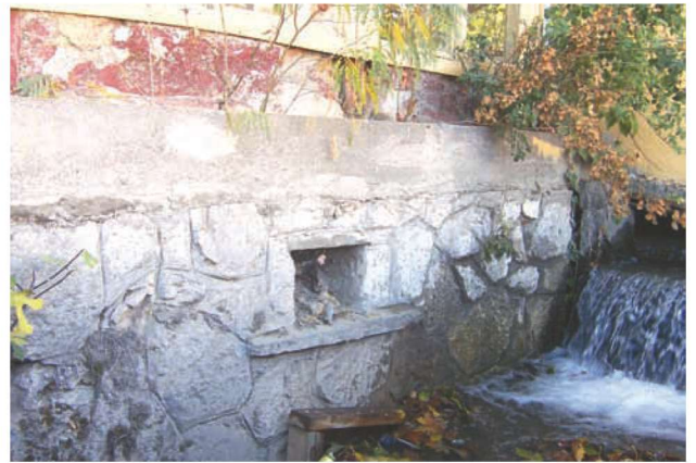
Res.27- Şamlılar Çeltik Fabrikası, kuzeydoğu cephesi, çarkın mil yuvası ve temel seviyesini oluşturan taş duvar
