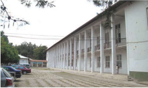
Res.40- İstiklal Mahallesi'nde 1940'larda inşa edilen eğitim yapılarından Endüstri Meslek Lisesi (O34.B9.855)
