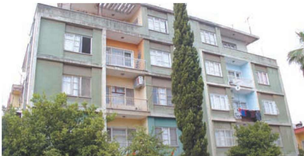
Res.44- 1-5 katlı konut dokusunun hakim olduğu Emek Mahallesi'nde Gümüş Apartmanı (O34.B9.1293)
