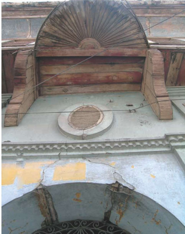
Res.20- Geleneksel yapıların cephelerinde çıkmaları taşıyan eliböğründelerin yanı sıra yer alan çeşitli bezemeler (O34.B9.245)
