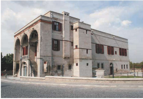
Res.19a- Talas geleneksel doku cephe örneği
