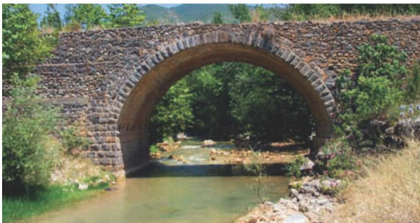
Res.12- Sabunsuyu Köprüsü
