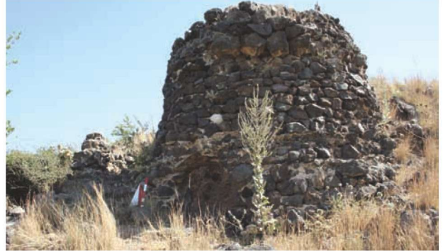
Res.7a- Deli Halil Antik Kenti Batı - yuvarlak yapı güneyden
