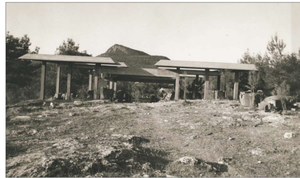
Res. 16. Turgut Cansever'in saçakları (Güney Kapı)
