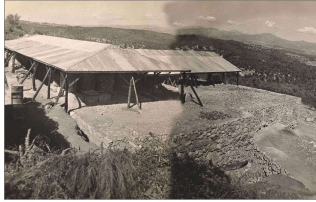
Res. 12. Geçici dalgalı saç çatı
