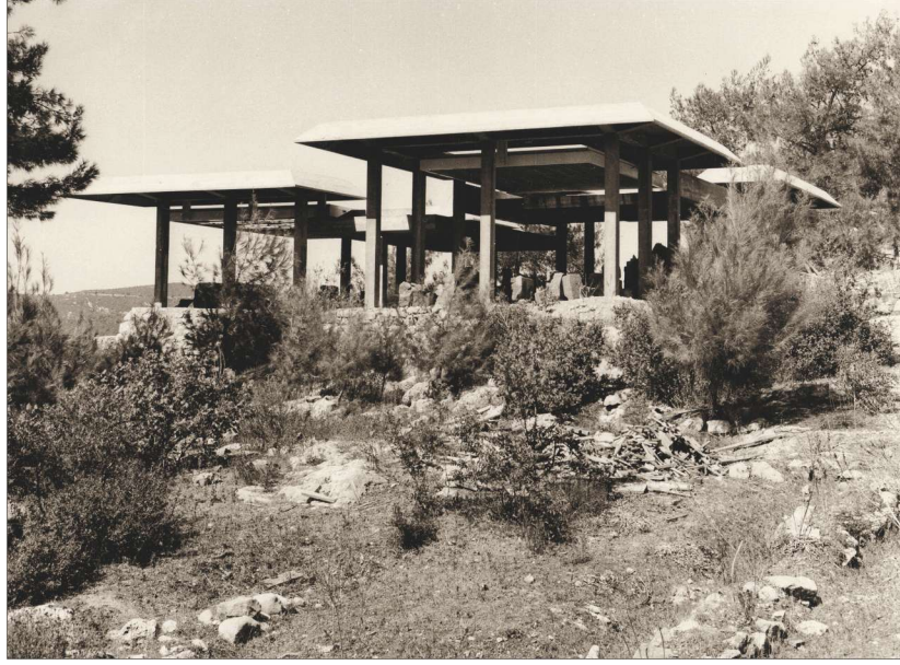
Res. 17. Turgut Cansever'in saçakları (Güney Kapı)
