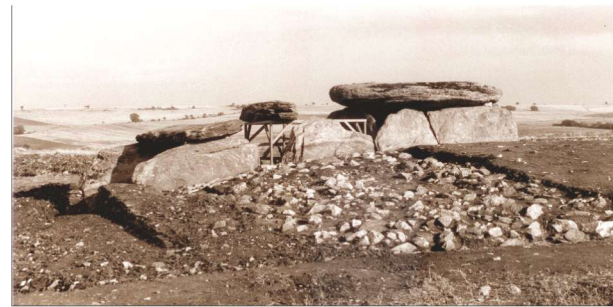
Res. 9. Demir kafes yapılıp taşlar üzerine konulduktan sonra
