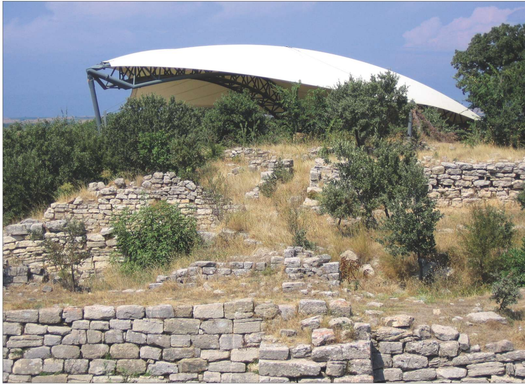
Res. 9. 2001 yılında Troia II -III dönemi kerpiçten yapılmış kale duvarı ve megaron yapısını korumak için yapılmış koruma çatısı (Troia Projesi arşivi)
