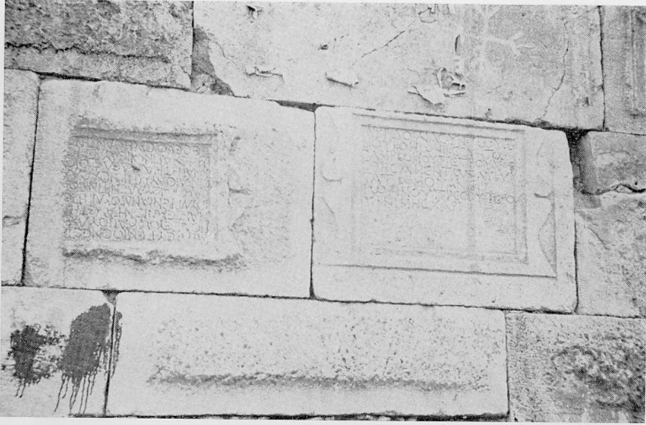
Res. 20a — Kadınhan'da duvar örgüsünde geç Roma (M.S. 3-4. asır) mezar taşları (İ. İlter). Fig. 20a — Late Roman sarcophagi (3 rd-4th Centuries A.D.) in wall construction at Kadınhan (İ. İlter).
