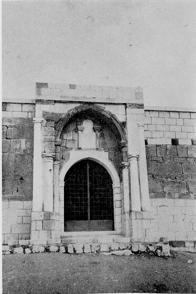
Res. 21 — Eğret han portalinde antik sütun ve başlıkları (İ. İltter). Fig. 21. Columns and capitals at the portal of Eğret Han (İ. İltter).
