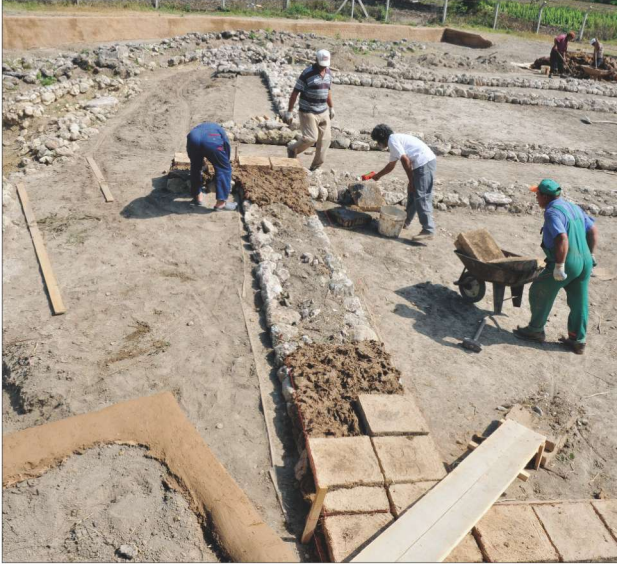
Res. 9. Model duvarların inşası; taş temel ve kerpiç dizisi
