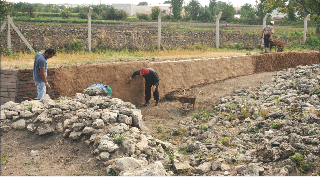
Res. 13. Kazı sınırlarında ahşap destek duvarı inşaatı
