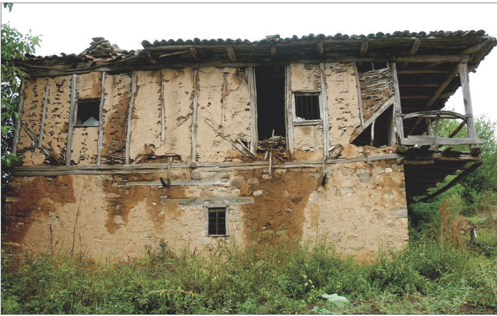
Res. 5. Zemin katı yığma, birinci katı dalörgü dolgulu ahşap karkas ev, Ahlatlı Köyü
