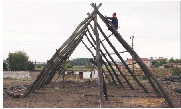
Res. 19. 1. Sergi Evi'nin inşaatını yapan Kamber Usta
