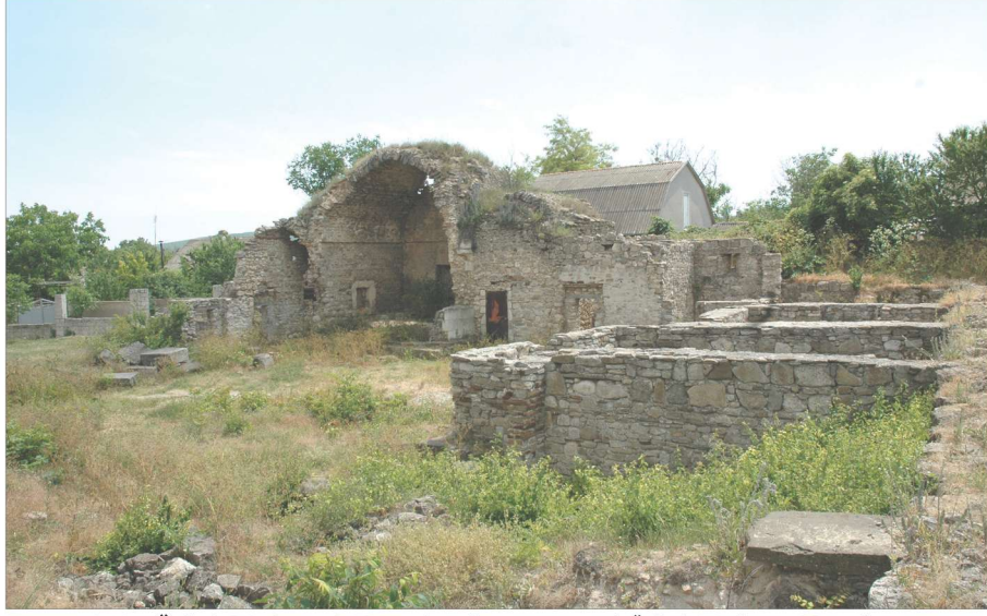
Fotoğraf 12 - Özbek Medresesi. Kuzeybatıdan görünüş. / Özbek Medrese. View from northwest.
