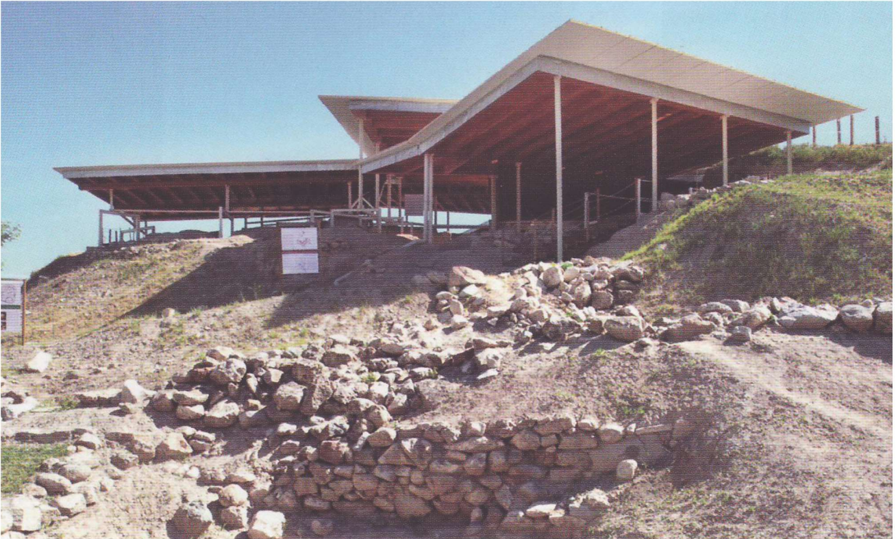
Fotoğraf 8 - Arslantepe koruma çatısı (Başgelen 2013: 16) / Protective shelter in Aslantepe (Başgelen 2013: 16).
