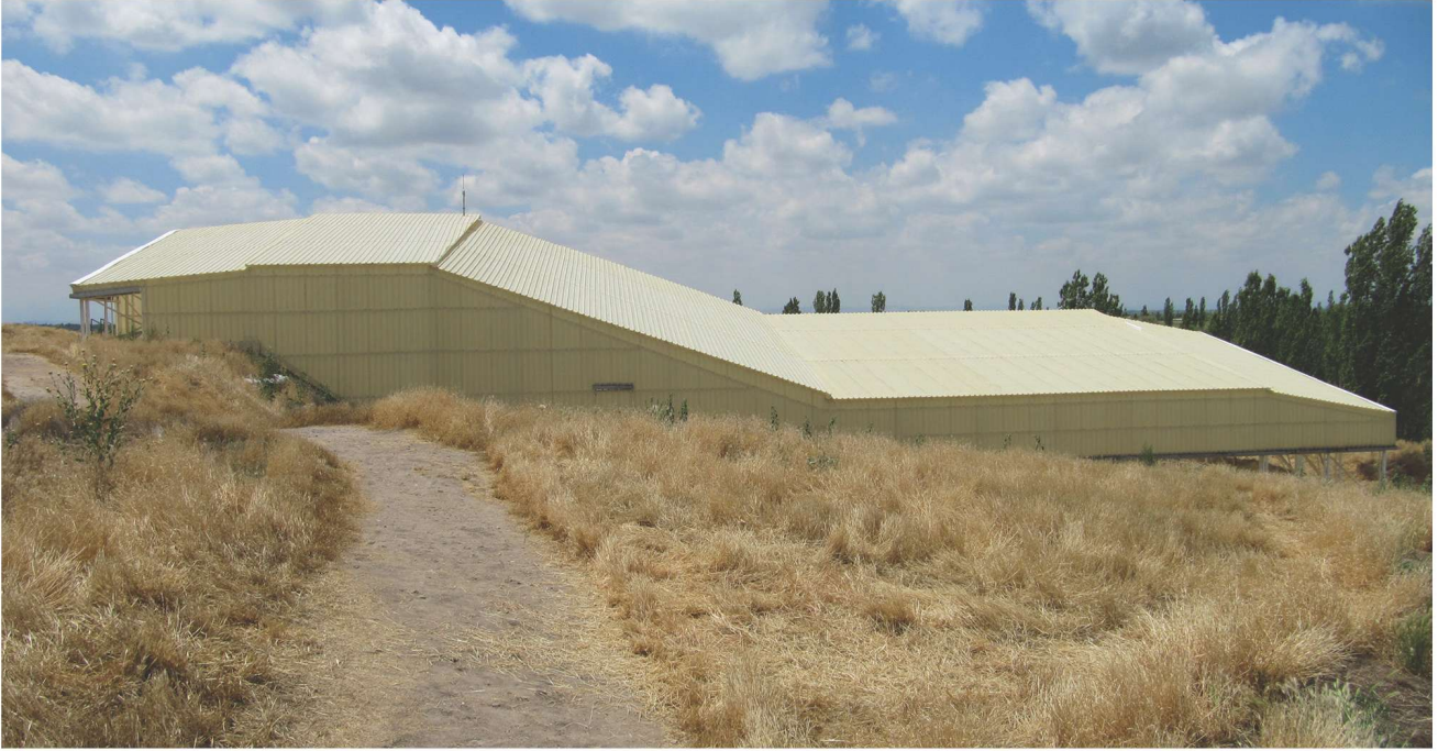
Fotoğraf 3 - Çatalhöyük Güney Kazı Alanı koruma çatısı (M. Savrum Kortanoğlu Arşivi) / Protective shelter over the south trench in Çatalhöyük. (M. Savrum Kortanoğlu's collection)
