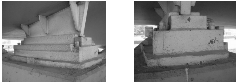
Şekil 2. Kompozit üst yapının çelik mesnetleri
