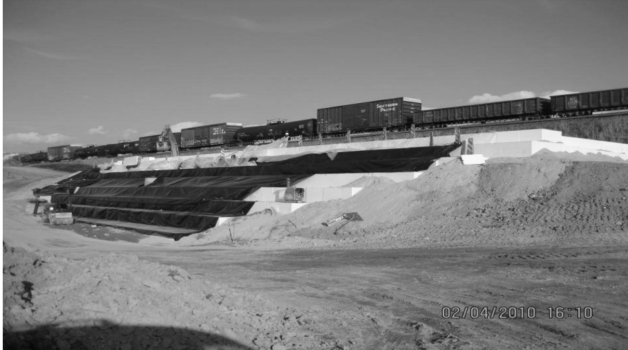
Şekil 1 EPS Köpük malzemenin hafif dolgu malzemesi olarak kullanımına bir örnek (FrontRunner Demiryolu Hattı İnşaatı, Salt Lake City, Utah)
