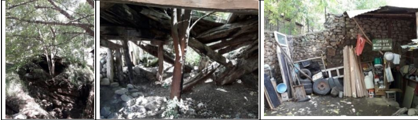
Şekil 2: Zaviye olabileceği düşünülen yapının çöken kırlangıç örtüsü, Sultan Melik Gazi Mescidi (2018) (Fotoğraflar: Yazarın arşivinden).
