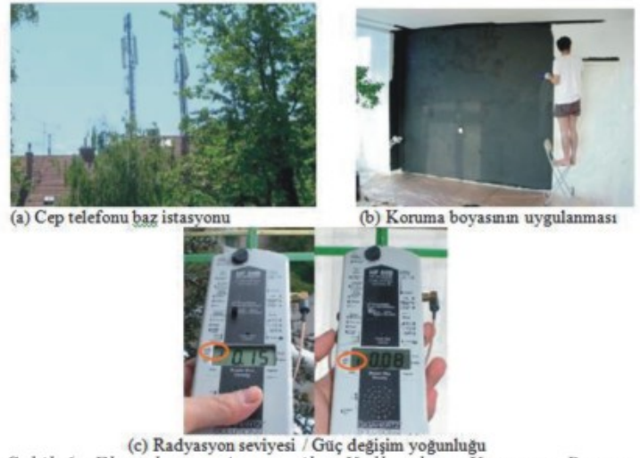
Şekil-6 Ekranlama Amacı ile Kullanılan Koruma Boyası Uygulaması
