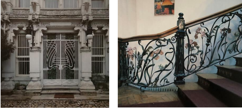
Fotoğraf 40. Hıdıva Sarayı Giriş Kapısı ve Merdiven Detayı 188
