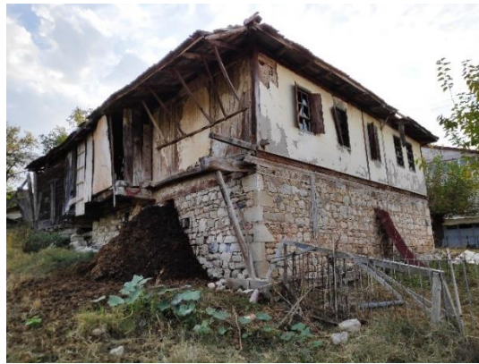
Şekil 13. Geniş çatı saçağının payandalarla desteklenmesi (Küçüksoy köyü).
