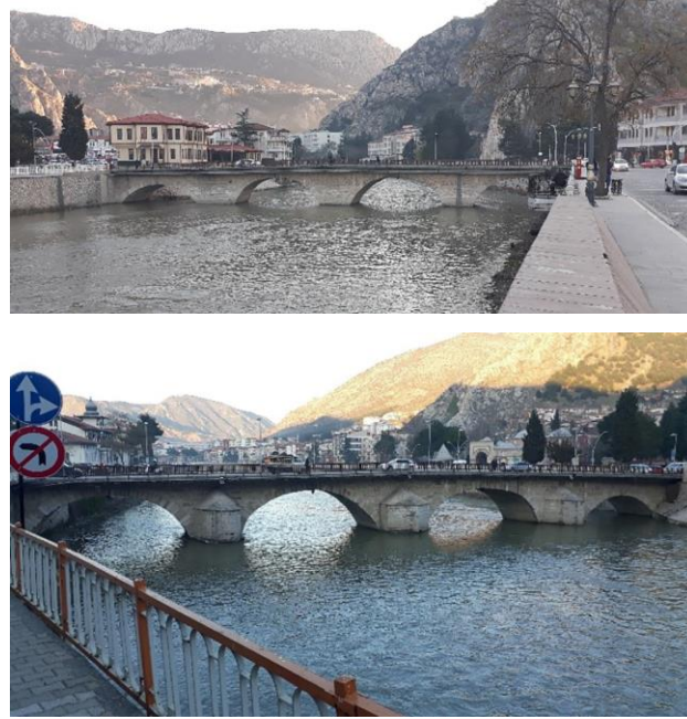
Şekil 2. Hundi Hatun (Kunç) Köprüsü Mansap ve Memba Görünümleri
