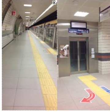
Şekil 17. Üsküdar-Çekmeköy Metro Peron Hissedilebilir Yüzey Ve Koruyucu Bariyerler (Dicle, 2019).
