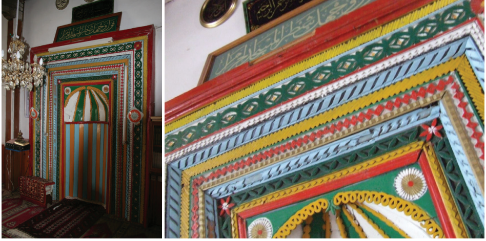
Fot. 27-28: Beyşehir Bayağsar Hızır Ali Paşa Camii mihrabının önceki durumu (Konya Vakıflar Bölge Müdürlüğü Arşivi, KVBMA)
