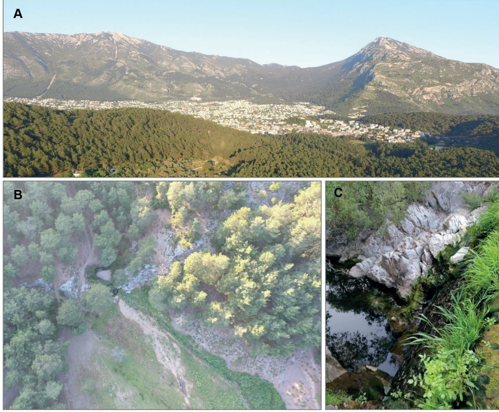
Şekil 17: Ovacık-Hisarönü yerleşimine batıdan bakış (A) ve Hisarönü Kayaköy arasındaki birleştirme boğazındaki alüvyonlarla dolmuş taşkın setti (B, C). Figure 17: View of the Ovacık-Hisarönü settlement (A) from the west and the alluvial-filled flood embankment in the gorge between Hisarönü (B) and Kayaköy (C).
