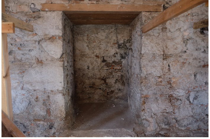
Fotoğraf 20- Avlu doğu duvarının kuzeyindeki niş.
