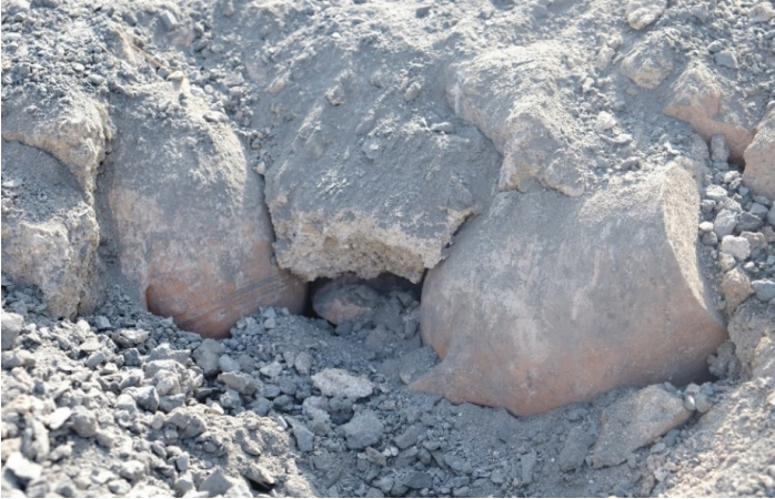
Fotoğraf 35- Kubbe ve tonozlar arasında kalan boşluklara yerleştirilen testiler.
