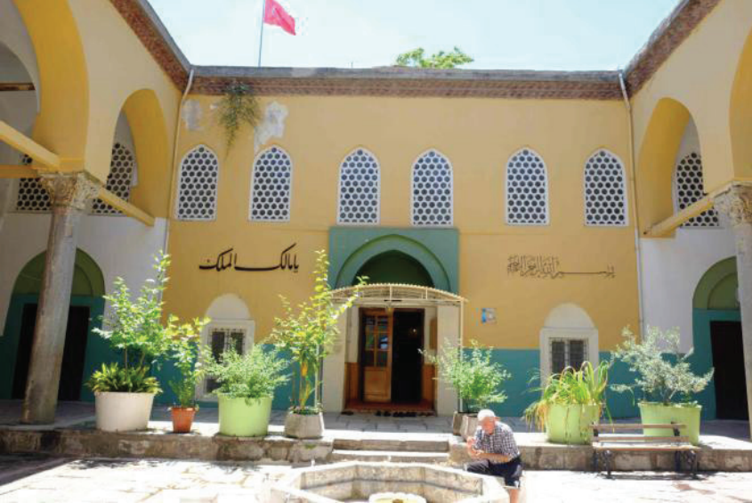
Fotoğraf 5- Ulu Cami. Onarım öncesi harim kuzey cephesi.
