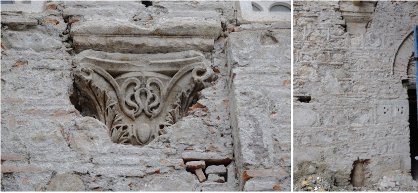
Fotoğraf 24- Duvar içerisinde kalan sütunlar.
