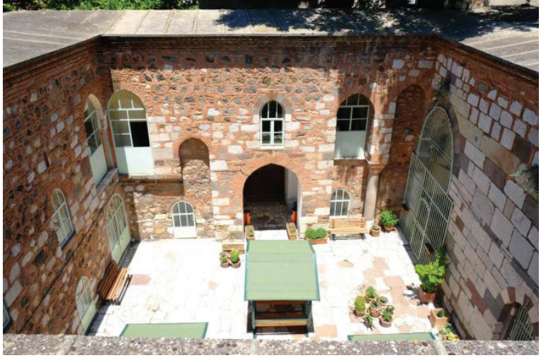
Fot. 13- Medrese. Onarım öncesi avlu kuzey kanadı.
