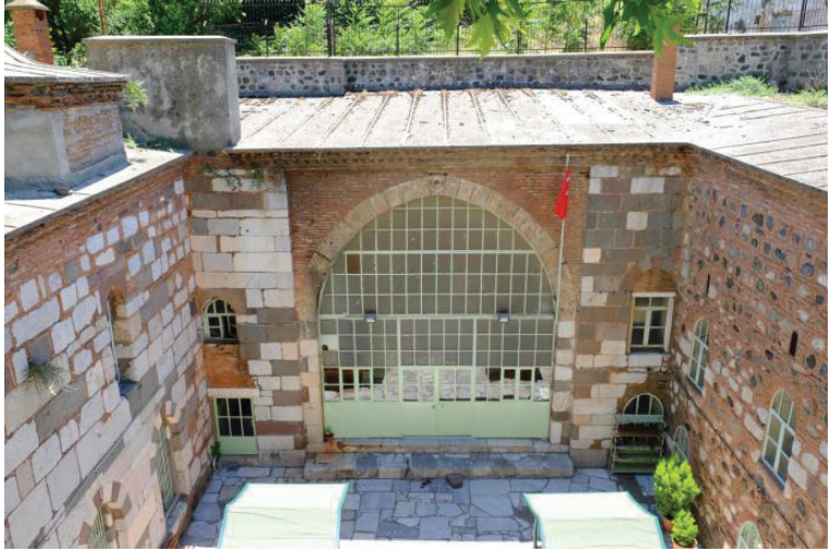
Fotoğraf 14- Medrese. Onarım öncesi avlu güney kanadı.
