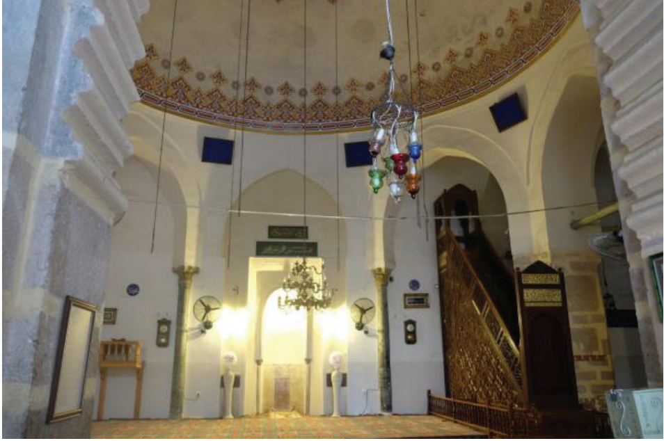
Fotoğraf 6- Ulu Cami. Onarım öncesi mihrap önü mekanı.
