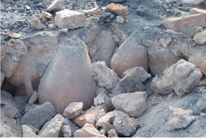
Fotoğraf 34- Kubbe ve tonozlar arasında kalan boşluklara yerleştirilen testiler.
