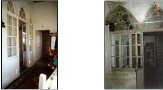
Şekil 4: Solda, Şehitkerim Mahallesi, 3405 Sokak, no:25. İç sofa ile dış sofayı birbirinden ayıran / bağlayan sivri kemerli kapı. (Kişisel arşiv,1998) Sağda Sofular Mahallesi, 2710 Sokak(43. Sokak) . İç sofaya açılan kapı (Kişisel arşiv, 1997).
