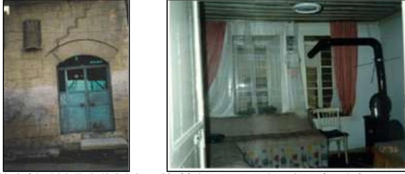
Şekil 7: Solda Sofular Mahallesi, 42 Sokak, no:22 giriş kapısının üstünde ara katta ahşap kafes pencere. Sağda Kızılmurat Mahallesi 42 Sokak, no:19 (Kişisel arşiv, 1998).
