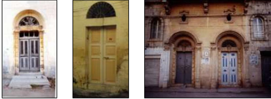
Şekil 3: Solda, Şehitkerim Mahallesi., 3405 Sokak, no:28. Ortada, Kızılmurat Mahallesi, 42 Sokak, no:19. Sağda, Şehitkerim Mahallesi, 3408 Soak, no:26-26A). (Kişisel arşiv, 1998)
