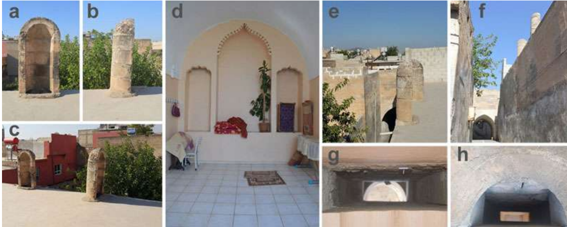
Şekil 4. Kendirci Mahallesi'ndeki bir konağın kuzeyden (a) ve batıdan (b) rüzgâr alan rüzgâr yakalayıcılarının kepçe ya da başlıklarının dam ya da teras çatıdan (c ve e) ve sokaktan (f) görüntüleri ile eyvanın arka duvarındaki nişlerin (d) üzerinde bulunan rüzgâr çıkışından damdaki rüzgâr girişine (g) ve damdaki rüzgâr girişinden ise aşağıdaki rüzgâr çıkışına bakış (h).
