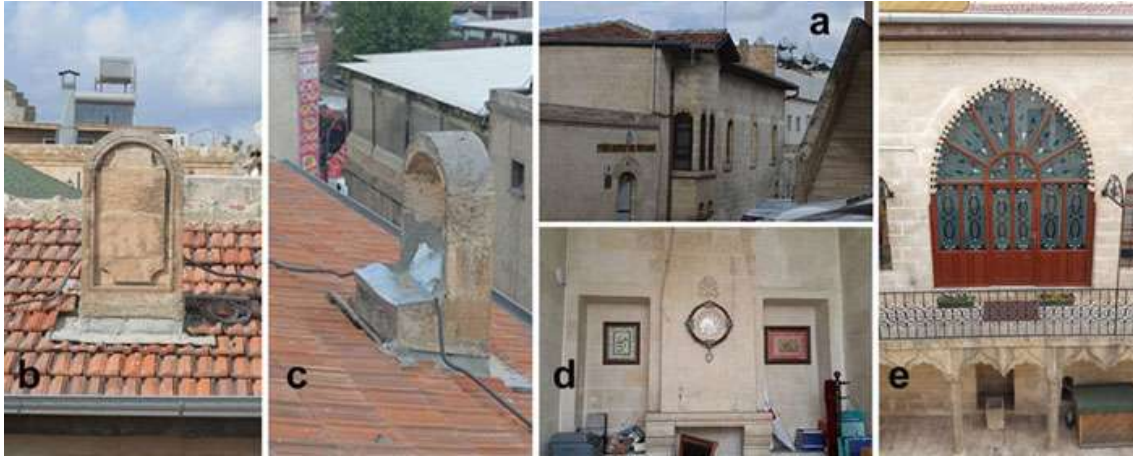
Şekil 8. Eyyübiye Belediyesi Yerel Yönetimler Konağı'nın (a) rüzgâr yakalayıcısının sokaktan (b) ve çatısından (c) görüntüleri ile eyvanın arka duvarındaki orta nişin (d) ve avluya açık olması gereken eyvanın (e) avludan görüntüleri.
