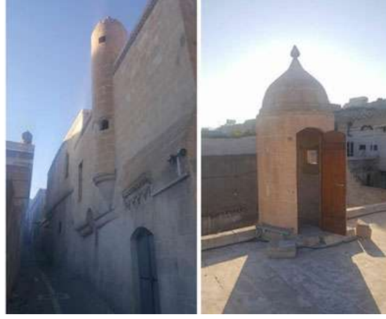
Şekil 13. Bir evin merdiven kovanındaki doğal boşluğun havalandırma kanalı gibi kullanıldığı dekoratif soğutma bacasının hem sokaktan hem de terastan görünüşü.
