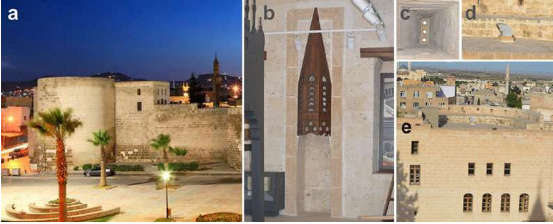
Şekil 10. Yenilenen Mahmudoğlu Kulesi'nin (a) [54] içindeki odada bulunan yenilenmiş nişin (b) üstündeki hava çıkışından yukarıya bakış (c) ve rüzgâr yakalayıcının yerine eklenen metal bacanın dıştan görünüşü (d ve e).
