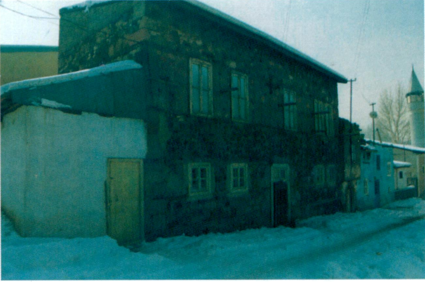
Resim 35 - 11 No'lu örneęe ait ön görünüş (Ketecioęlu evi)
