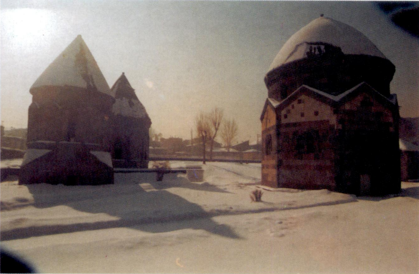
Resim 2 - Üç Kümbetlerin kuzeyden görünüşü
