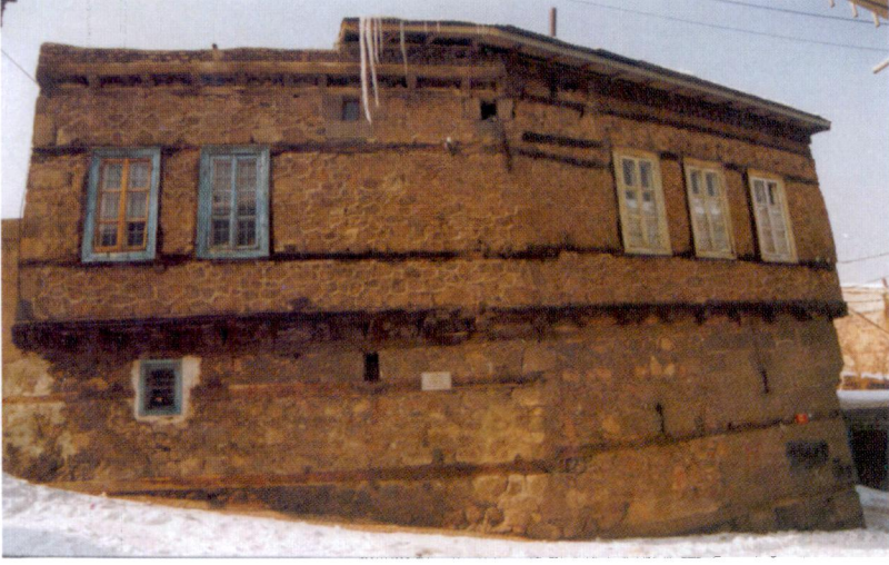
Resim 17 - 2 No'lu örneęe ait doęu görünüşü (Kilisliler'in evi)
