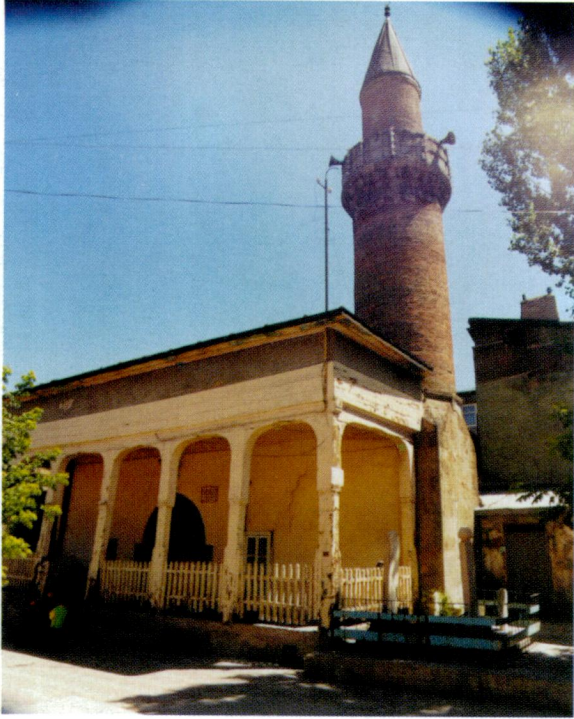
Resim 10. Camiinin avlusundan bir görünüş
