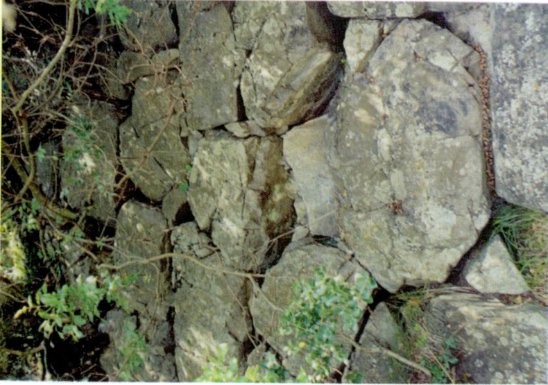
Res.17 - Sur duvarı detayı, Akalan Kalesi
