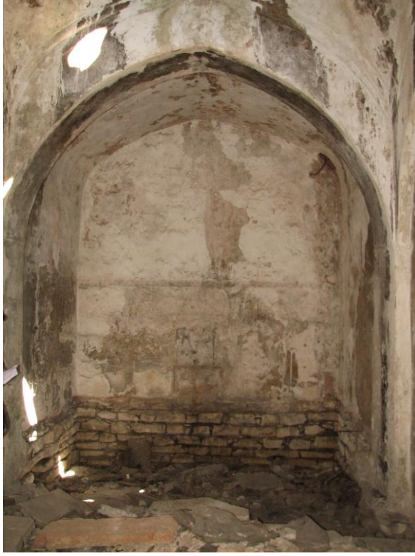
Resim 9. Urla Hersekzade Ahmet Paşa Hamamı. Kadınlar kısmı Sıcaklık mekanı.
