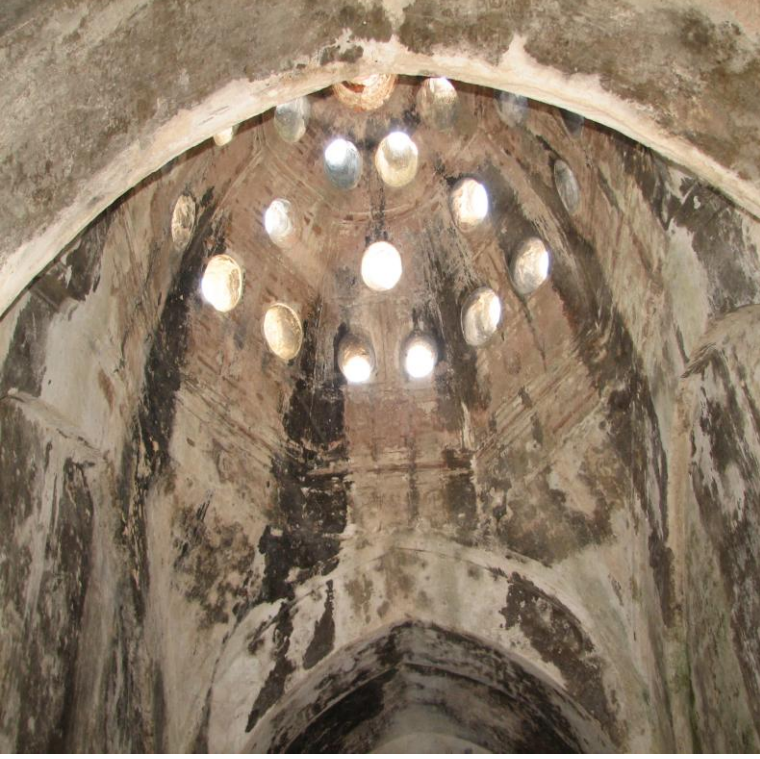
Resim 10. Urla Hersekzade Ahmet Paşa Hamamı. Kadınlar kısmı Sıcaklık mekanının örtüsünden detay.
