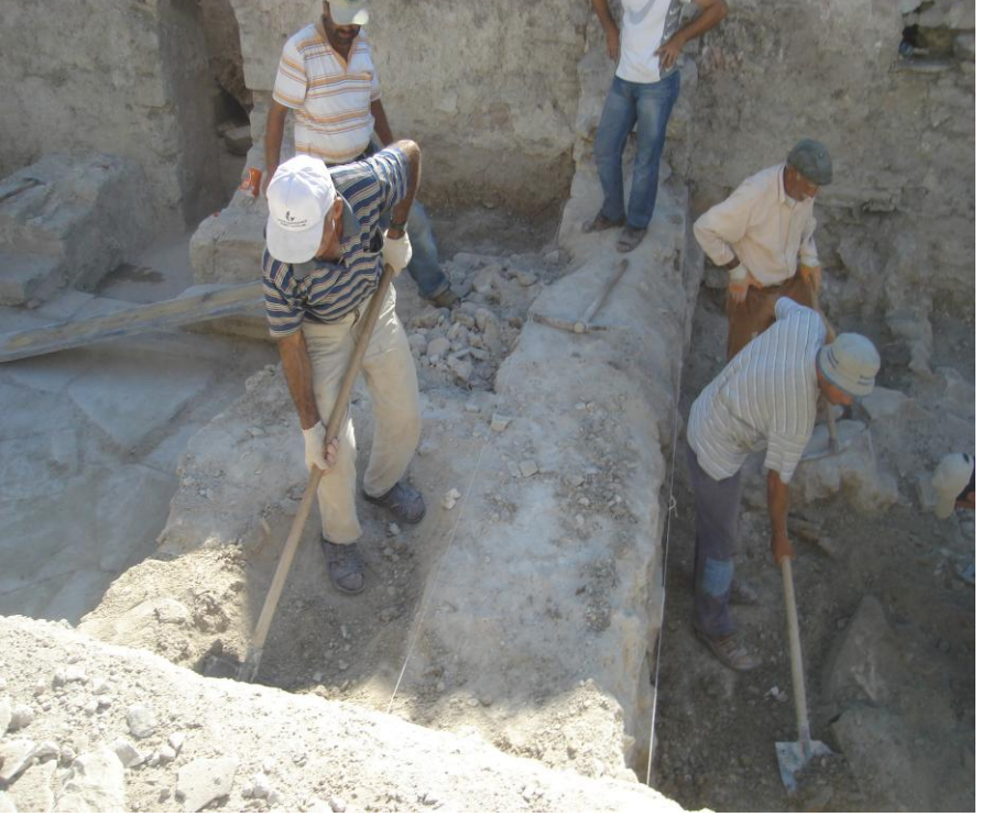
Resim 5. Urla Hersekzade Ahmet Paşa Hamamı. Soyunmalık mekanları arasındaki duvar kalıntısı.
