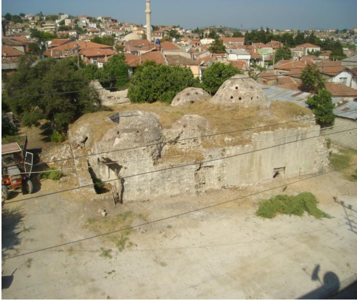
Resim 1. Urla Hersekzade Ahmet Paşa Hamamı. Kazı öncesi kuzeydoğudan genel görünüş.
