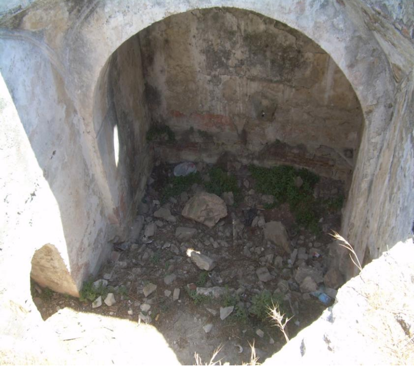
Resim 6. Urla Hersekzade Ahmet Paşa Hamamı. Erkekler kısmı. Sıcaklık mekanı.
