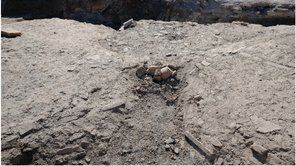
Fot. 2: Manisa Ulu Cami avlusunun kuzeydoğu revakının örtü sisteminde kullanılan testiler (Fotoğraf: C. Gürbıyık).
