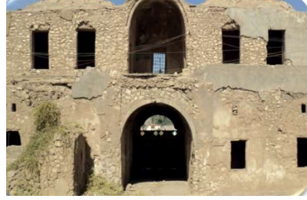
Görsel 11: Güver Kışlasının kuzey cephesinin görünümü.
