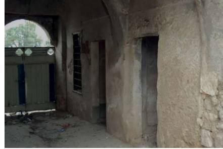
Görsel 13: Kuzey batı cephesindeki odalar.
