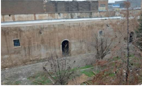
Görsel 22: Kışlanın batı cephe odaları.
