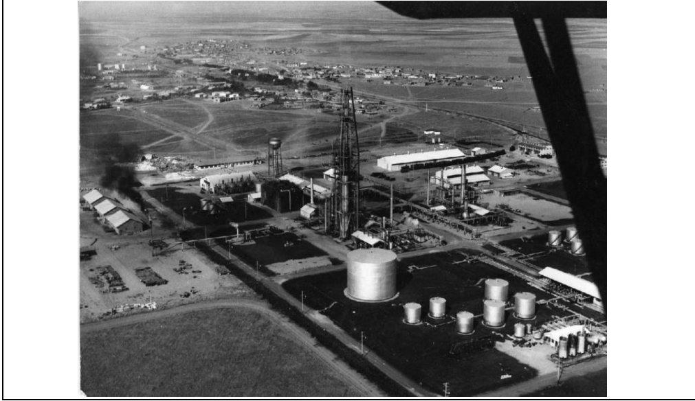
Fotoğraf 3. İlk Rafineri İnşaatı ve İluh Köyü, 2017.
