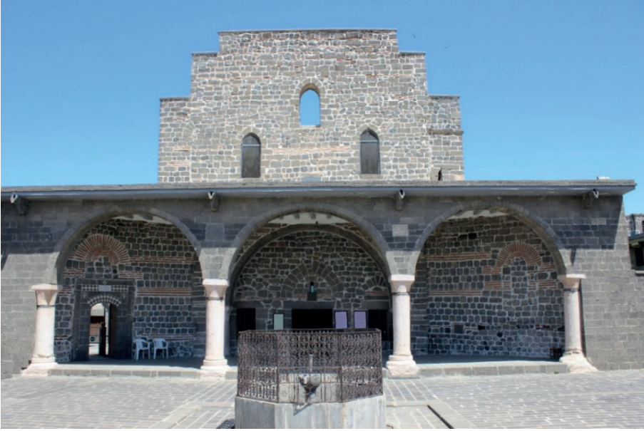
Fotoğraf 1: Diyarbakır Meryem Ana Kilisesi'nin Batı Cephesinde Bulunan Giriş Kapısı
