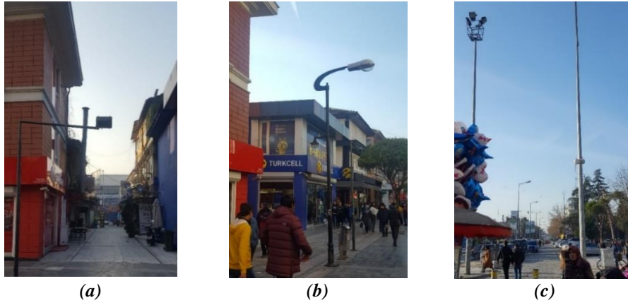
Şekil 19. (a) Gaziantep Caddesindeki ara sokakların aydınlatılması için konulan spot lambalar, (b) Sokak lambaları, (c) Sokak başlarındaki büyük spotlar.
