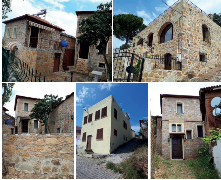
Foto 2: Pelitköy İçerisinde Restore Edilip Kullanılan Bazı İkinci Konutlar.
