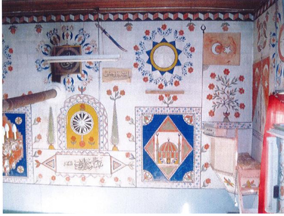
Resim 20. 2013-14 Restorasyonu öncesi doğu duvarı kalem işleri
