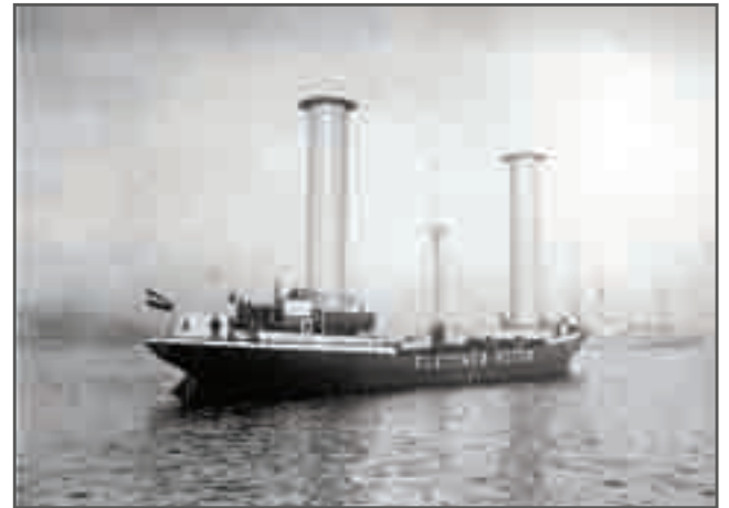
Şekil 20. Flettner rotorunun uygulandığı BUCKAU gemisi [7]
