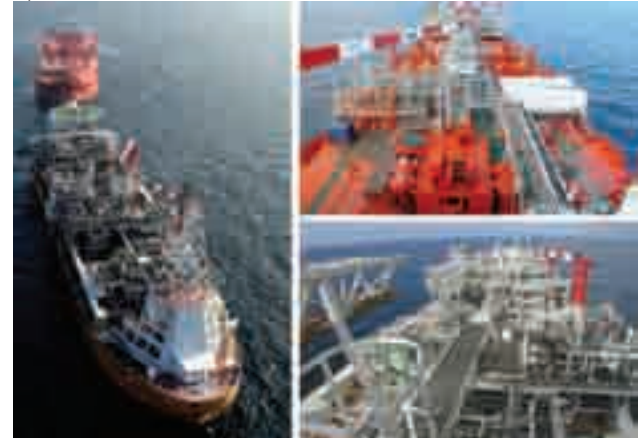
Fotoğraf 2. FPSO yapılarında güverte üstü boru hatları
