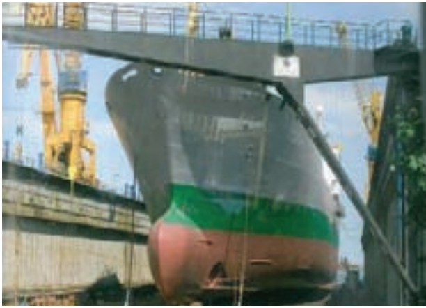
Şekil 10. Santierul Naval Constanta S.A. Tesisleri [10]
