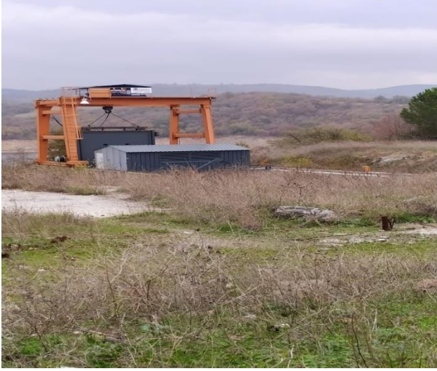
Şekil 3. Cebri borunun baraj gövdesinden girdiği nokta
