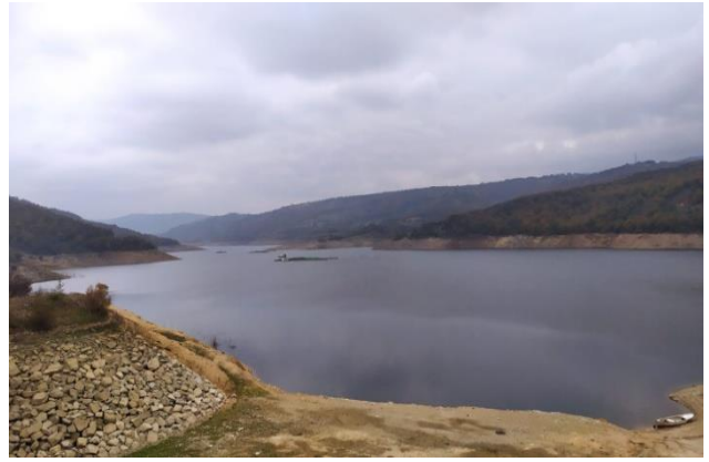
Şekil 2. Manyas Hidroelektrik Santrali ve Barajı
