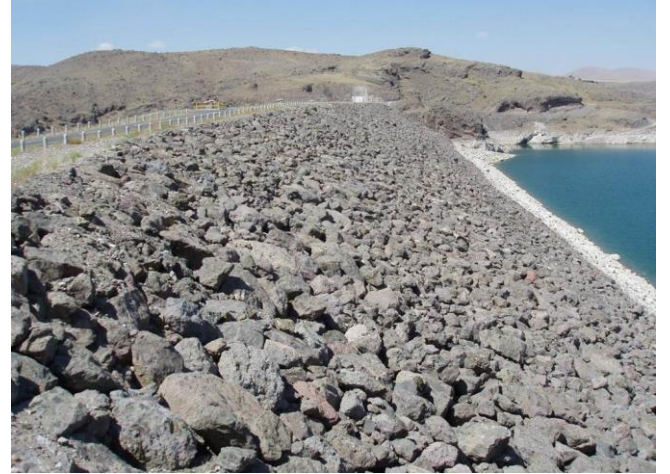
Şekil 6. Rip Rap Malzemesi
