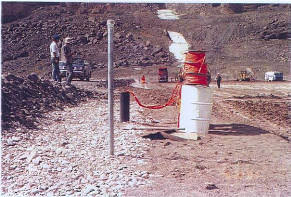
Şekil 8. Gövde İnşaatı Sırasında VWP'lerin Tesisi
