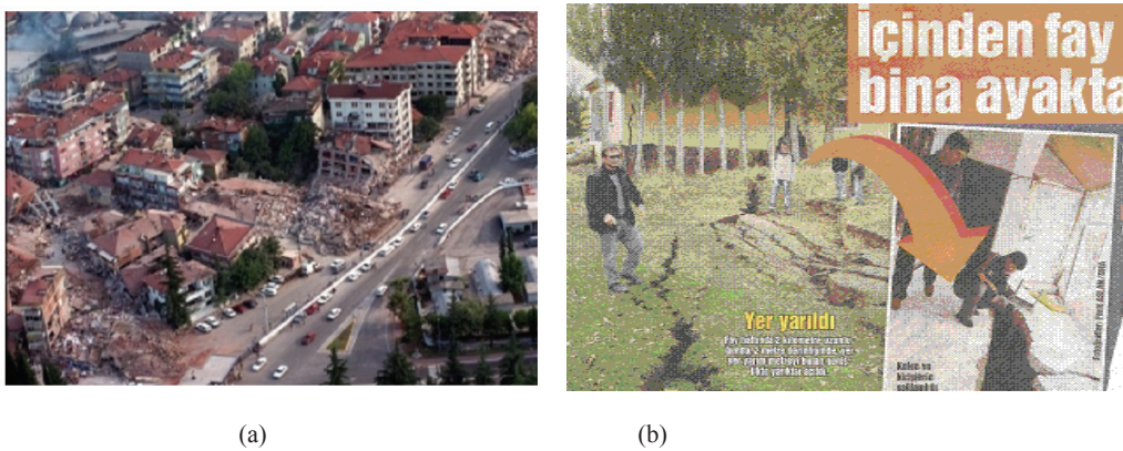
Şekil 3. (a) Sınırlı mevkide deprem ağır hasarı (URL-3) ve (b) Depremde oluşan fay üzerinde hasarsız bina (basın, 2011).
