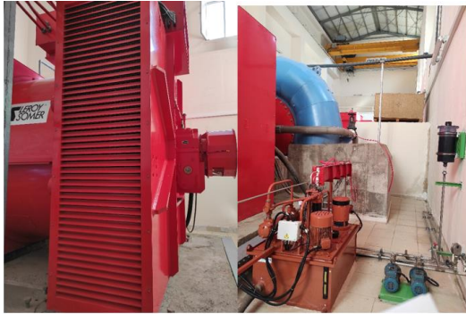
Şekil 12. Havalandırma Sistemi ve Yatak Yağlama Sistemi.
