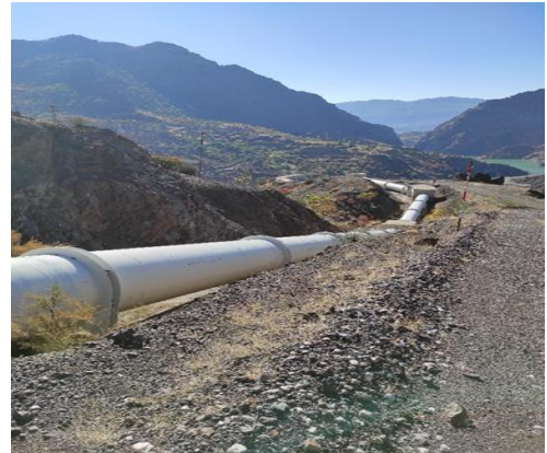
Şekil 10. Sırımtaş HES Cebri Boru Detayı
