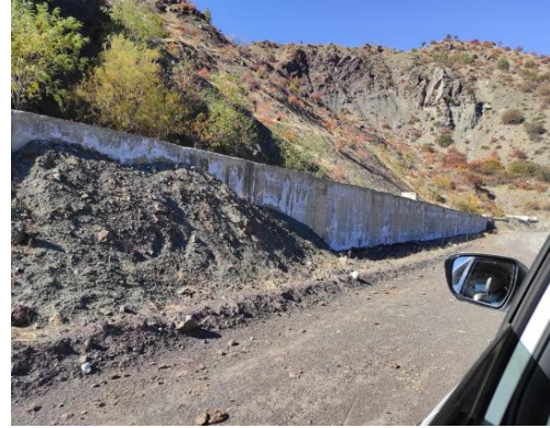
Şekil 9. Sırımtaş HES İletim Kanalı.
