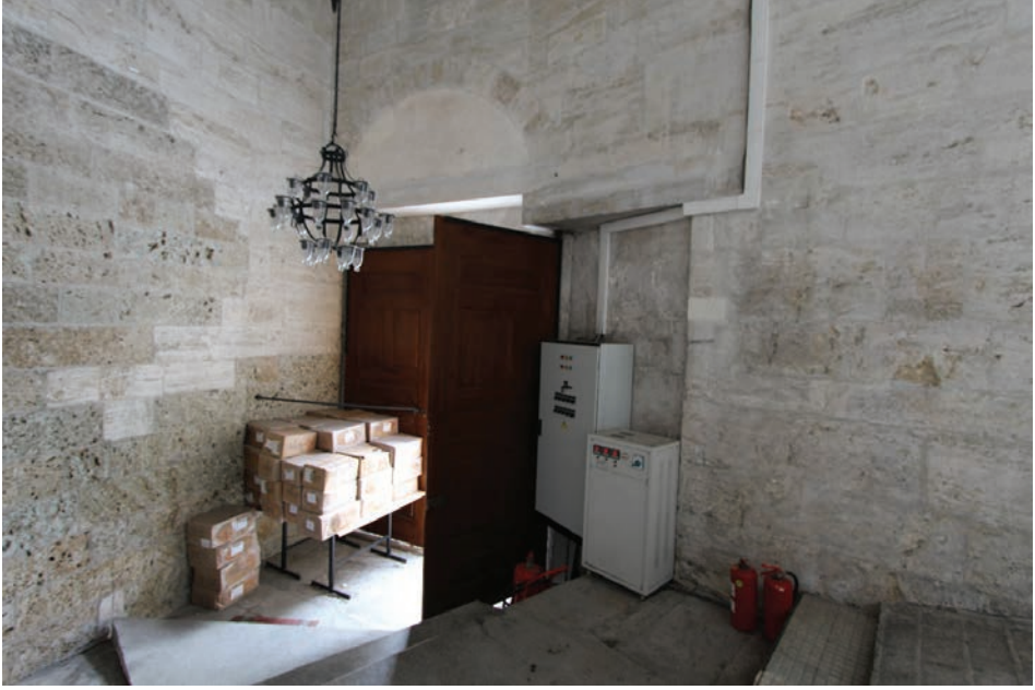
Fotoğraf 21: Nuruosmaniye Camisi Hünkâr Mahfili Rampa Taçkapısı Arka Yüz
