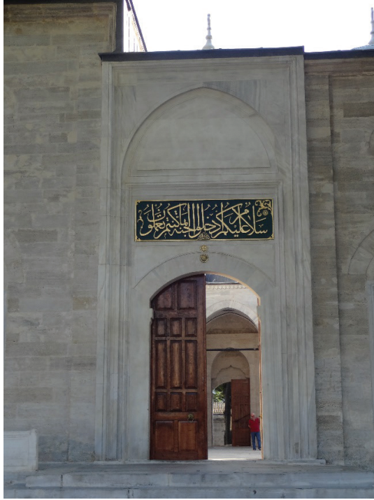
Fotoğraf 24: Üsküdar Yeni Valide Camisi İç Avlu Doğu Taçkapısı
