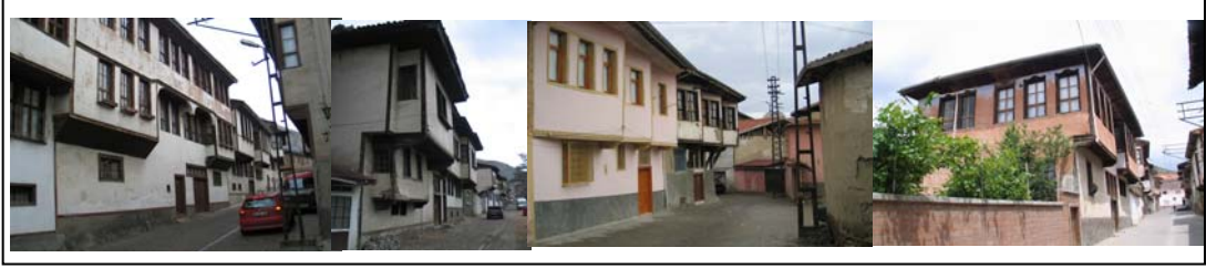
Şekil 9. Çeşitli şekillerde çıkmalar
