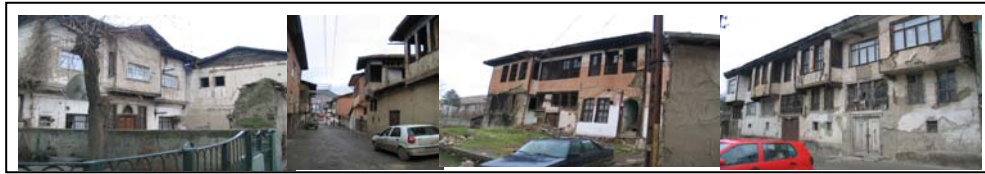
Şekil 3. Çalışma alanında bulunan bakımsız evler
