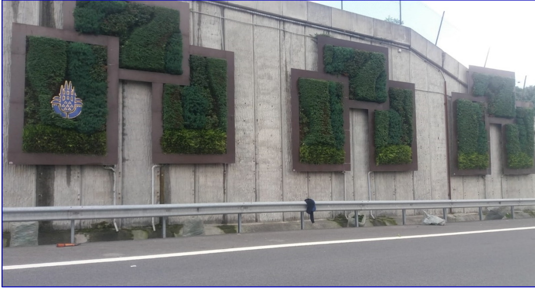
Şekil 3. Seyrantepe yol kenarında bir yeşil duvar uygulaması (Foto: İBB Arşivi).
